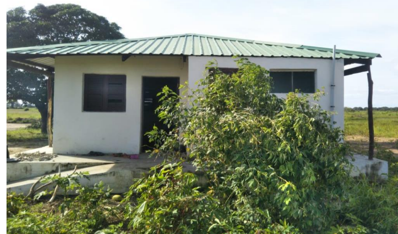
Casa de material convencional protegida contra os ventos fortes: Distrito da Ilha de Mocambique, foto tirada no dia 12 de Março 2022
