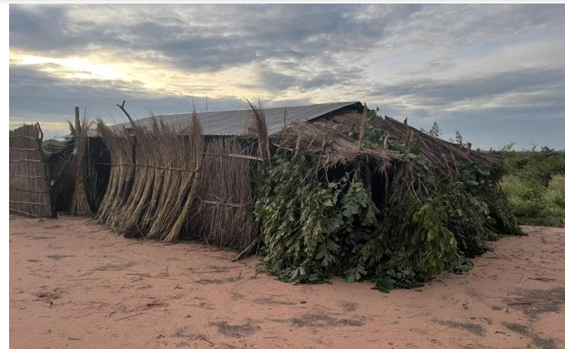
Casa de material precario protegida contra as chuvas fortes: Distrito de Angoche, foto tirada no dia 12 de Março 2022
